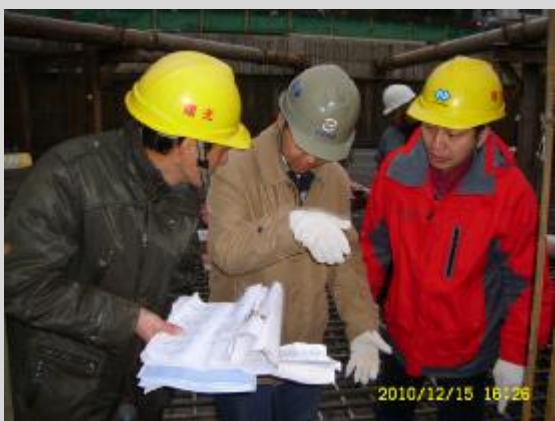
图为项目经理张云连(右一)带伤在工地检查工作
